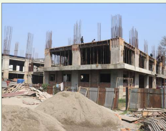
निर्माणाधिन सरुवारोग भवन
